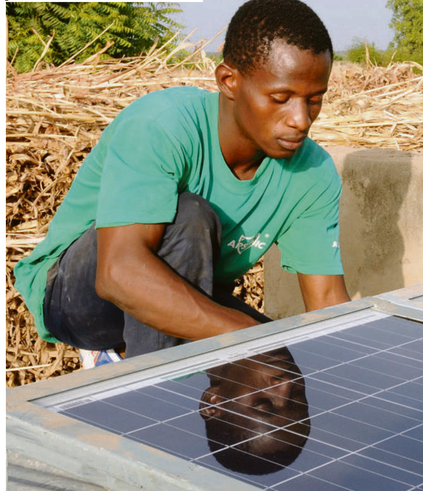
Installation d'un système solaire du programme Micresol par un technicien burkinabé. Fondem
